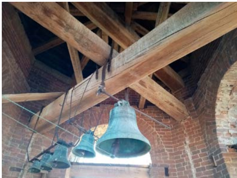
Рис. 4. Пример системы крепления на колокольне (храм св. Димитрия Солунского с. Сухая Вязовка)
