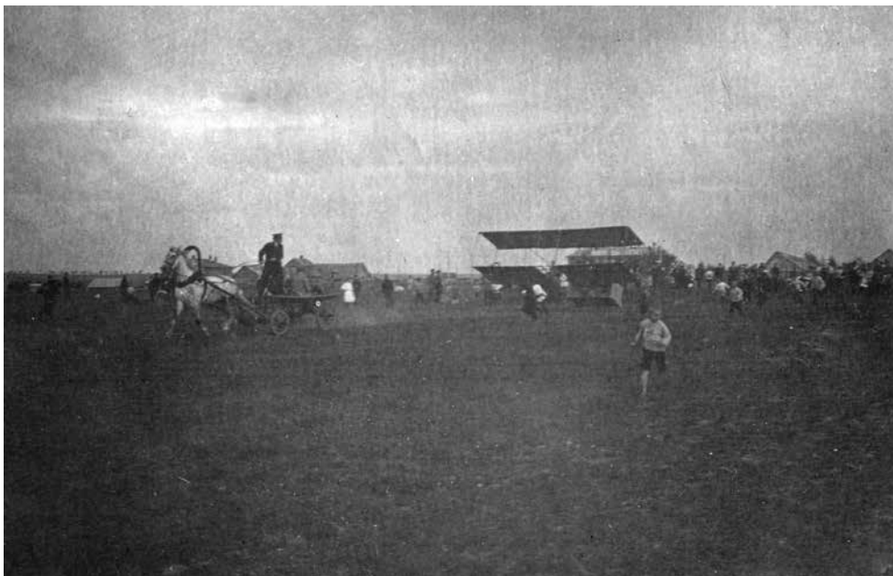
Запуск планера с помощью конной тяги. Планер сконструирован П.П.Соколовым и П.Н.Нестеровым. Нижний Новгород, 1911 г.
