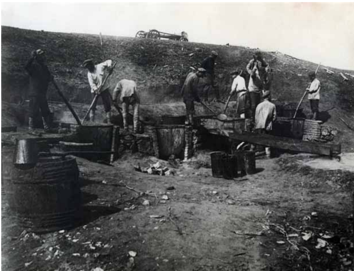
Варка гудронного песчаника кустарным способом в 1929 г.
