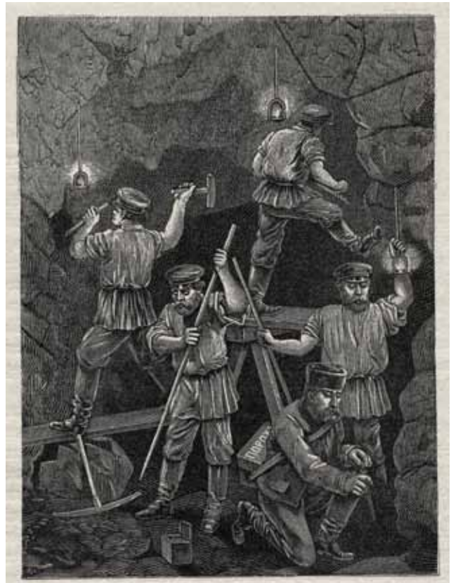
Добыча асфальта в штольне под г. Сызрань [43]
