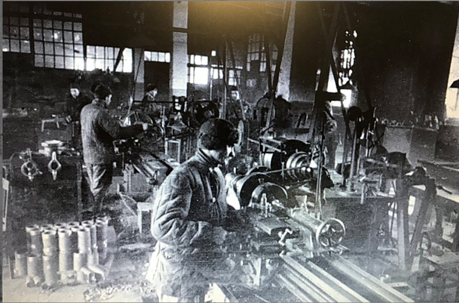
Токарный цех Моторостроительного завода №24
