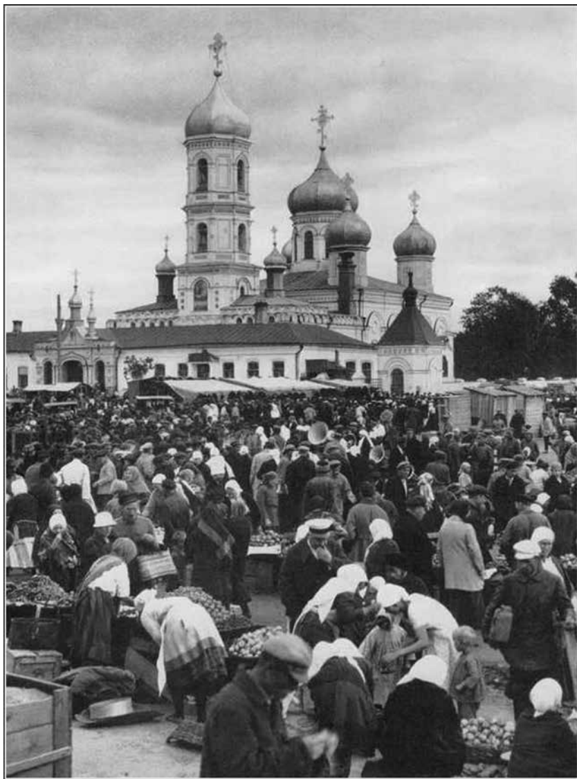
Ильинская церковь. Начало XX в.
