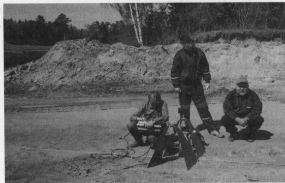
Фото 3, 4. Н.Л. Небритов. Работа в ООО «Пайплайн Сервисес ЛТД». Строительство переходов под руслами рек. Май 2002 г.
