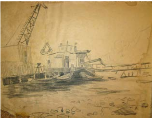
Рис. 1. Работы в районе Силикатного оврага. Разгрузка.
