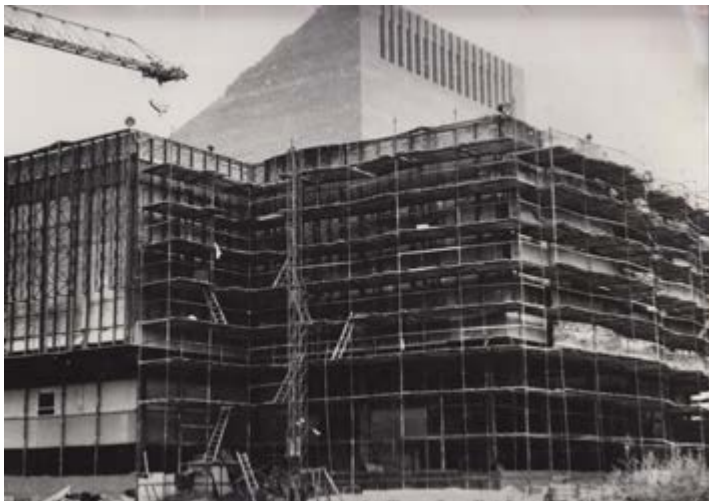
Рис. 1. Строительство Куйбышевского филиала Центрального музея В.И. Ленина. Середина 1980-х годов.
